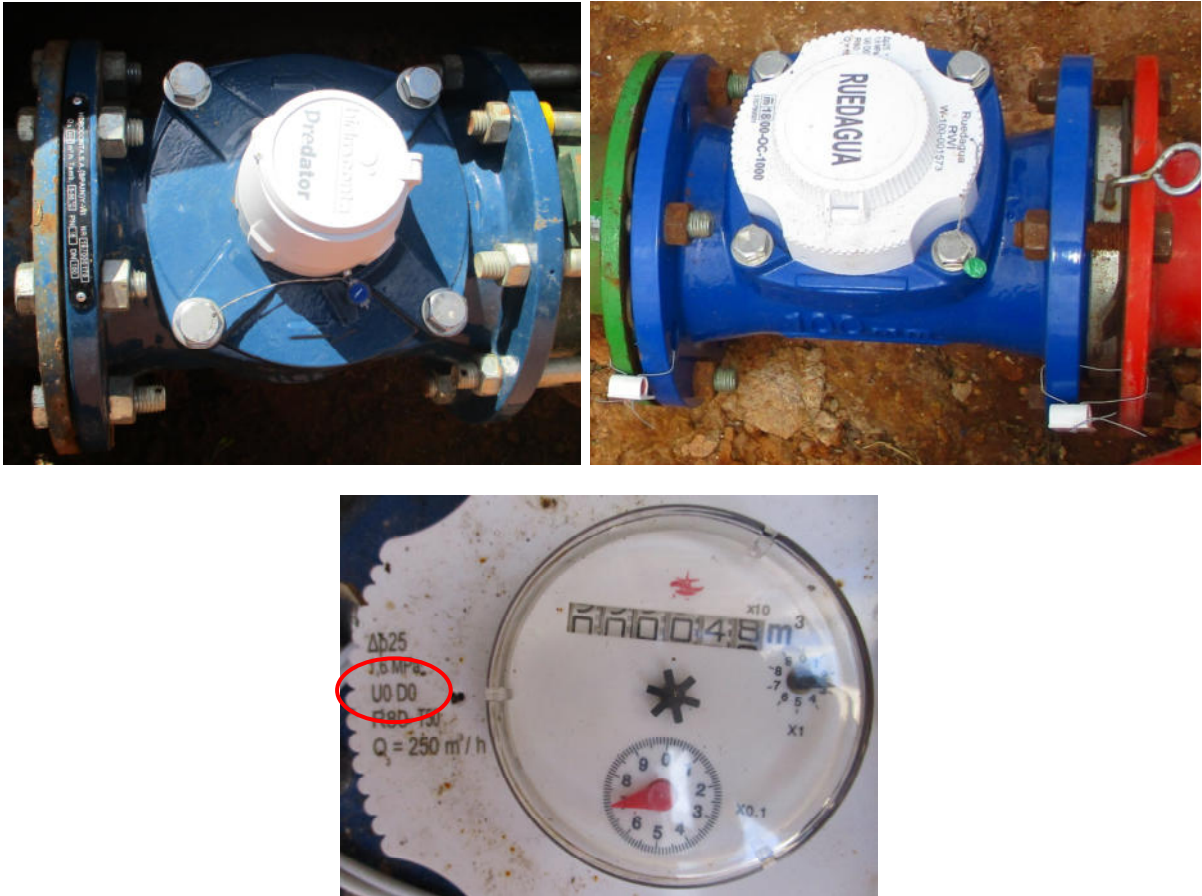
Figura 3.29. Ejemplo de contadores que no necesitan tramos rectos. Se indica U0, D0.
