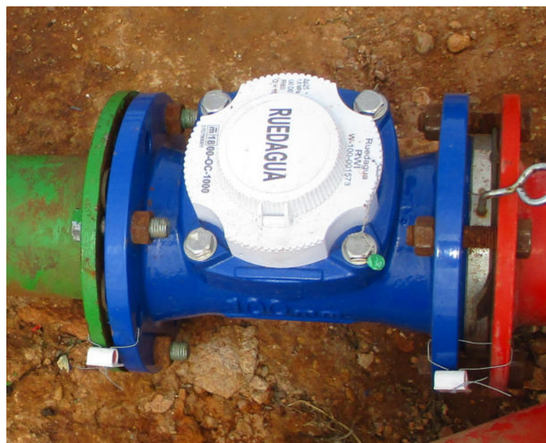
Fig. 4.11. Precintos formando eje. Incorrecto.
