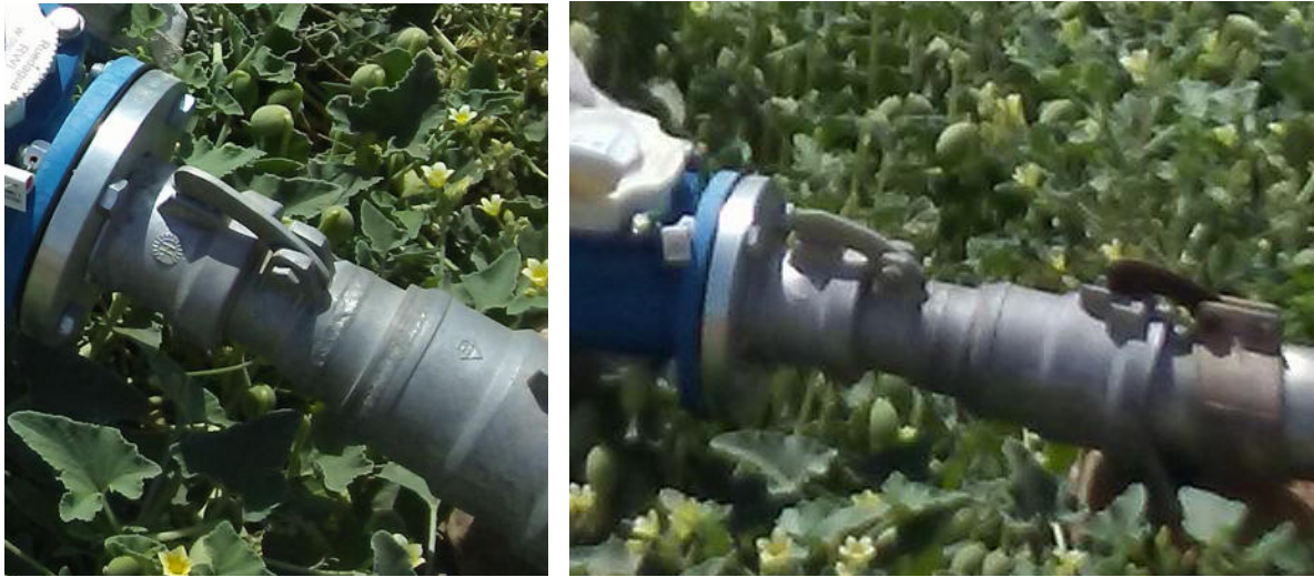
Figura 3.18. Uniones incorrectas aguas abajo de un contador. El desmontaje de las mismas da acceso al interior del contador.
