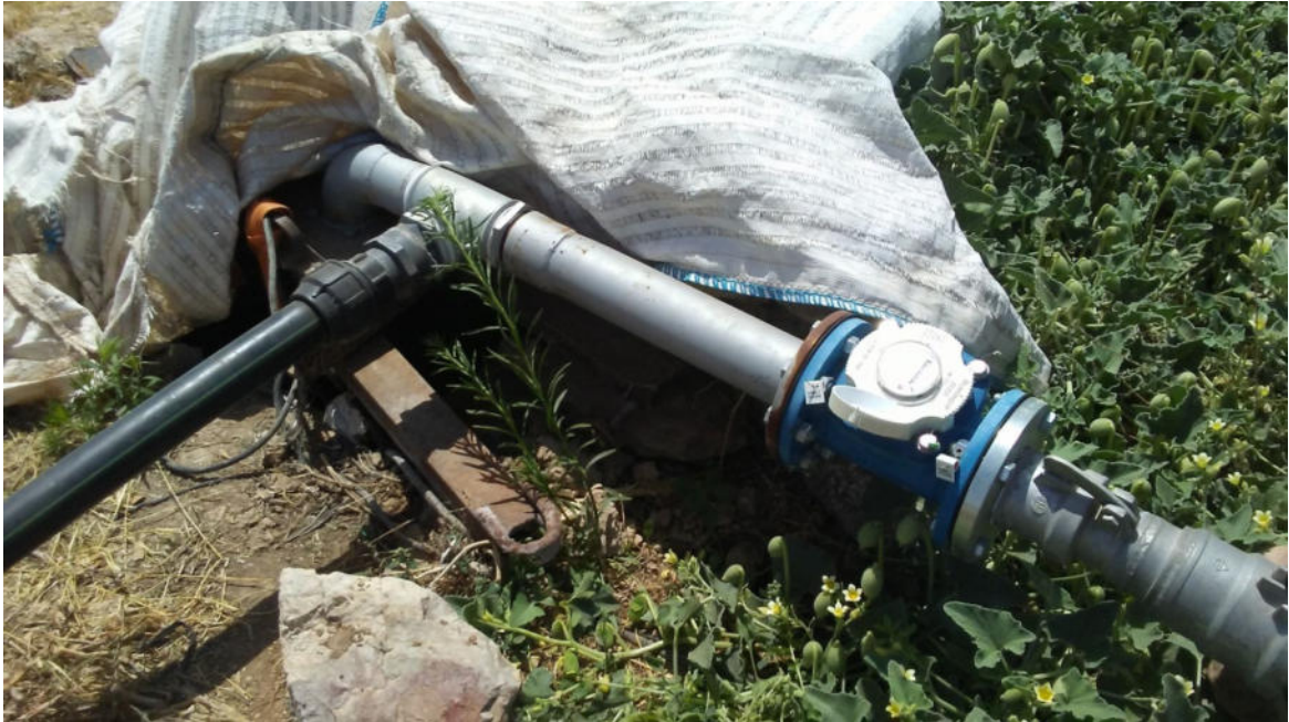
Figura 3.19. Instalación incorrecta. Derivación antes del contador. Unión no válida aguas abajo del contador que permite acceso directo al interior del mismo. En este caso sólo se ha precintado el contador, no se han precintado uniones, bancada, etc.
