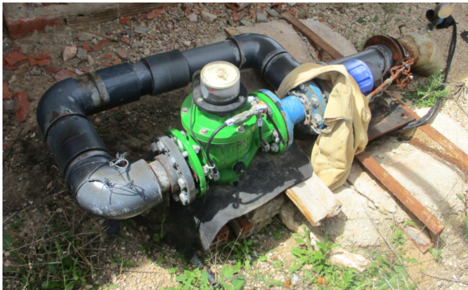
Fig. 4.15. Contador de válvula. No requiere tramos rectos.
