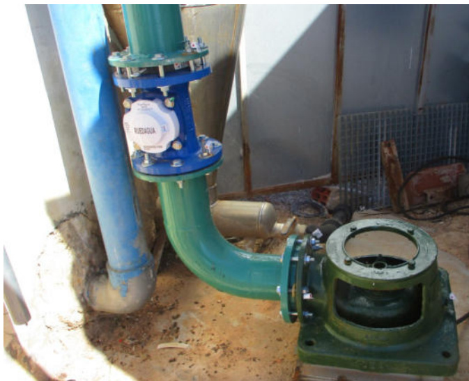
Figura 3.28. Contador instalado verticalmente. Es posible siempre que lo permita el fabricante. La sensibilidad en estos casos suele ser menor que en horizontal.
