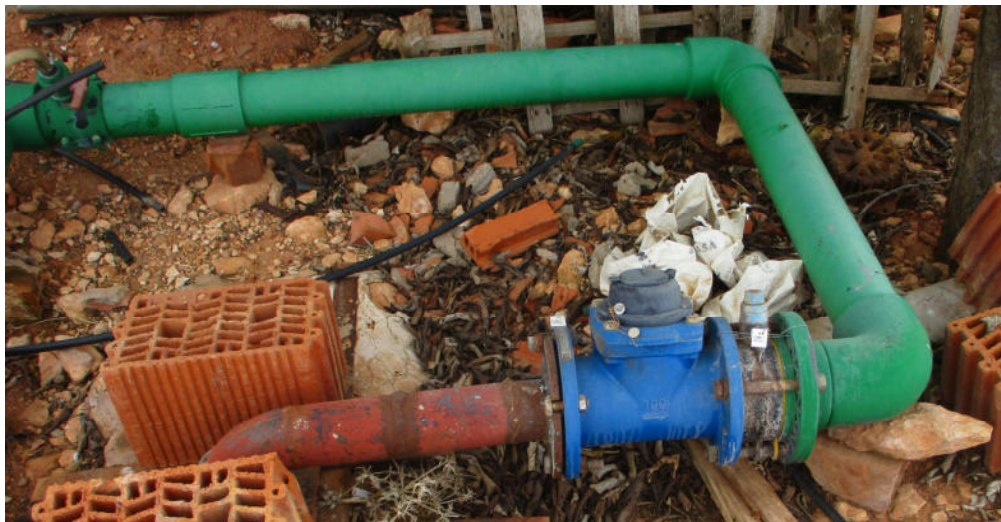
Figura 4.3. El tramo aguas abajo consta de dos codos que no dan acceso al interior del contador.
