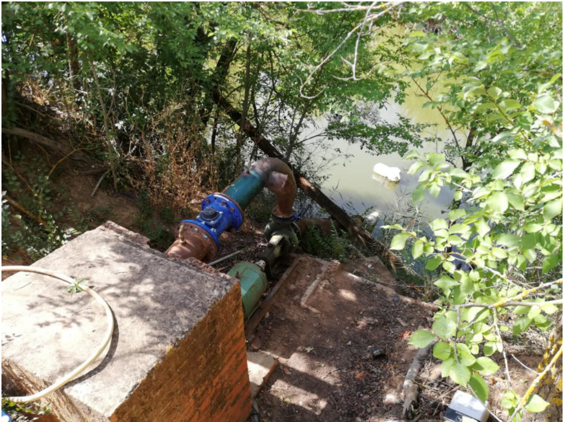
Figura 3.21. Instalación incorrecta. No se respetan las condiciones de instalación del contador. Insuficiente tramo recto antes del contador después de un codo.
