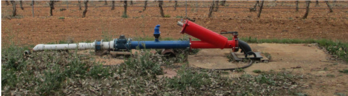
Figura 3.14. Filtro antes de contador.
