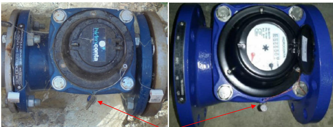
Fig. 4.8. Precintos de fábrica
