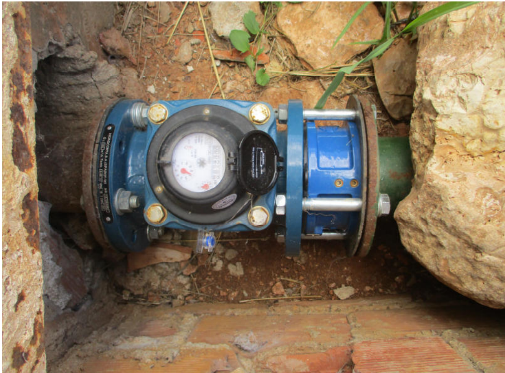
Figura 3.27. Tubería no visible entre captación y contador. Antes de precintarse comprobar que la misma es visible en el interior de la caseta, no existen derivaciones y cumple resto de requisitos antes de precintarse. Si la tubería está enterrada y no es visible, no se debe precintarse.
