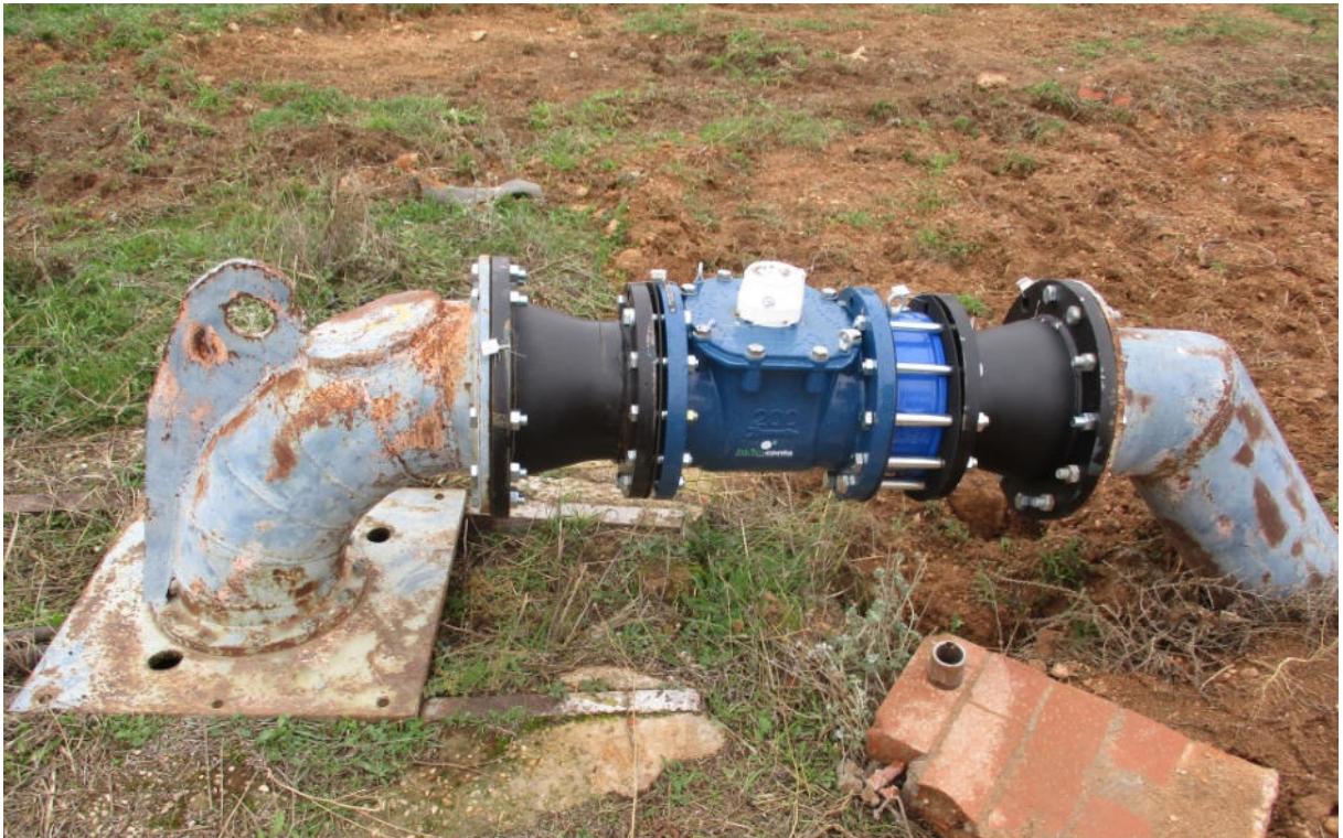
Fig. 4.18. Instalación precintada, en todos sus tramos.
