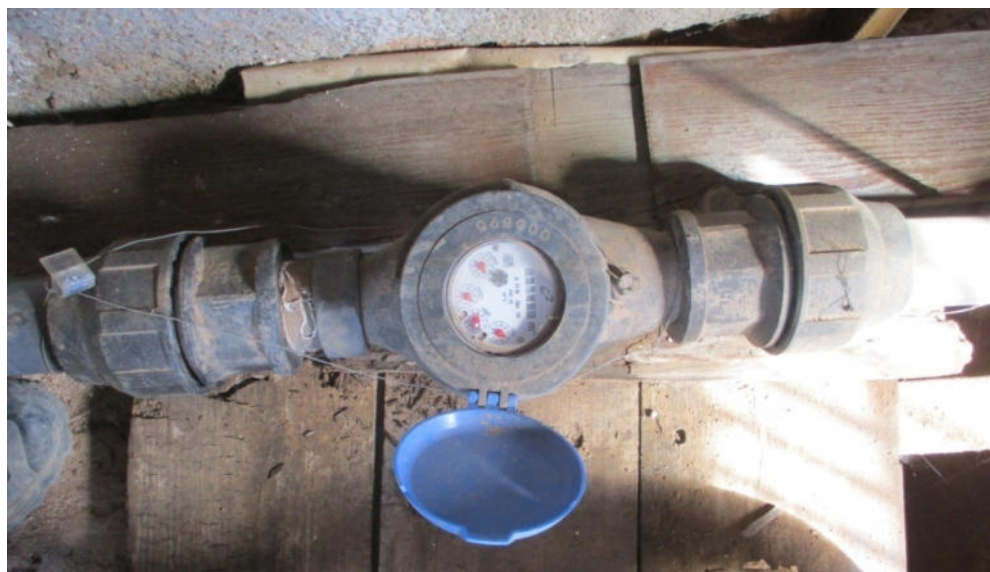
Fig. 4.13. Contadores de chorro múltiple precintado
