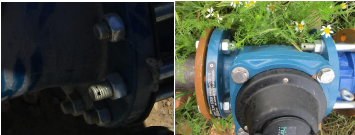
Figura 3.8. Tornillos preparados para precintar.
