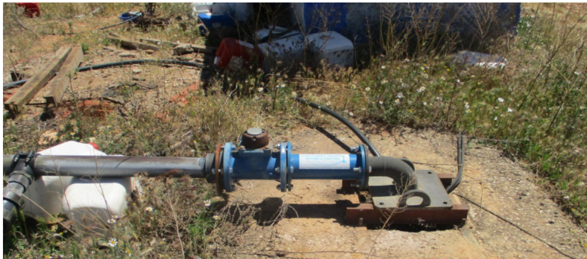
Figura 3.16. Carrete corrector. Exteriormente, indistinguible de un tramo de tubería normal.
