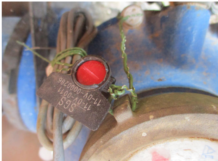
Fig. 4.9. Precintos de SGS, entidad verificadora de contadores
