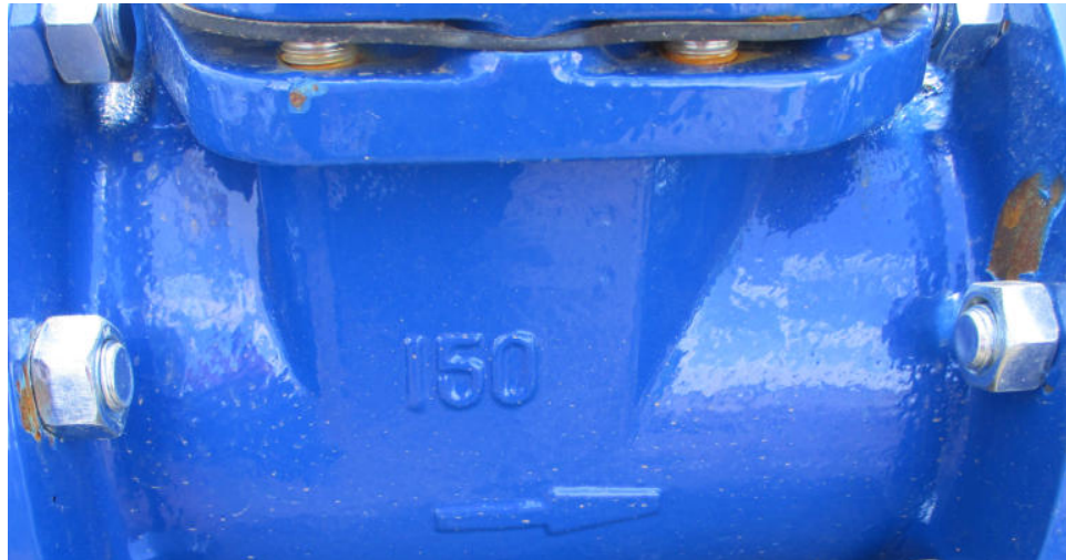
Figura 3.7. Dirección del flujo. Indica sentido instalación del contador.
