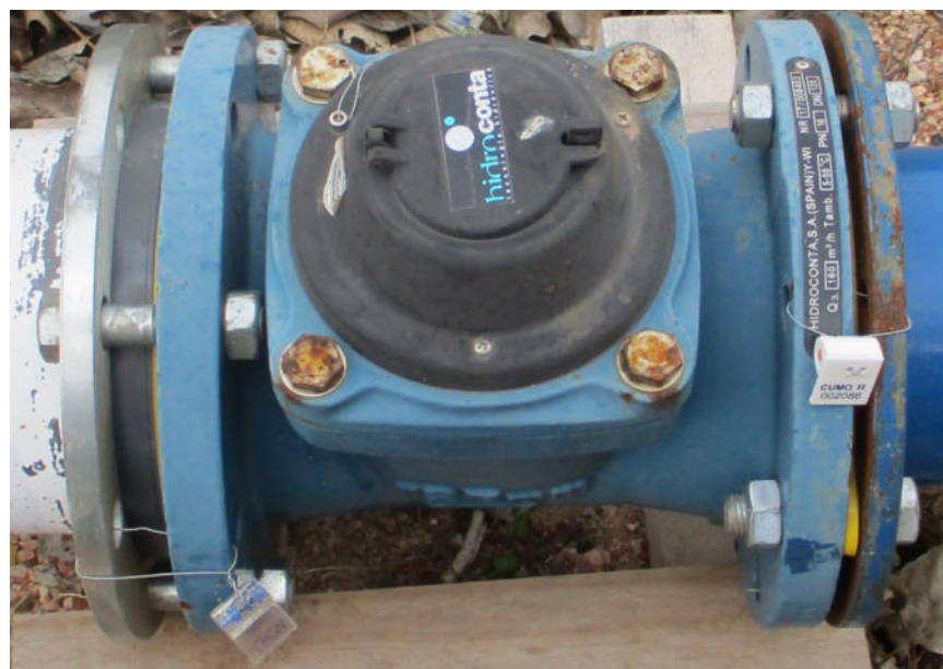
Fig. 5.2. Coexistencia de precintos. Solo se desprecinta el tramo necesario.
