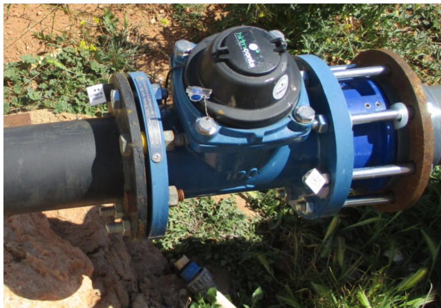
Fig. 4.12. Ejemplo de precintos que no conforman eje. Correcto.
