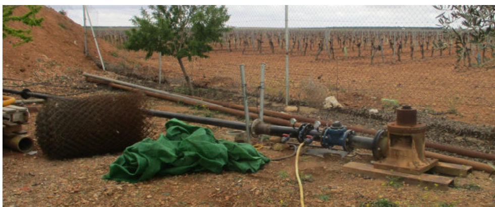
Figura 4.4. Precintado suficiente tramo recto. Modificar instalación si es necesario. Hay que eliminar la derivación justo posterior al contador, facilita el acceso al interior del mismo.
