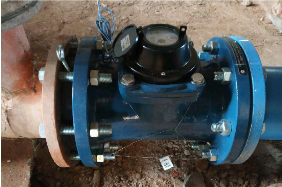
Fig. 4.13. Precinto de tornillos enfrentados.
